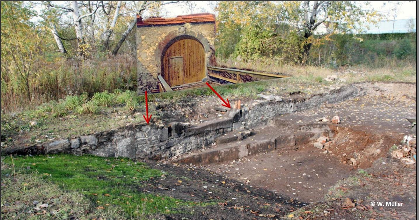
Freigelegter Mühlgraben im Bereich des Brückentores. Zu sehen ist die Sandsteinschwelle mit seitlichen Prellsteinen und den Aussparungen (Auflager) für die Tragebalken der Brücke. (siehe auch Fotos unten)
