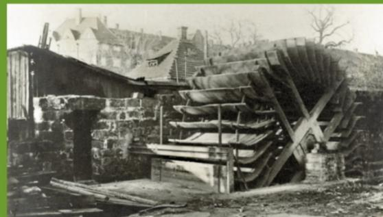
Letztes Wasserrad (Zuppinger Rad) auf dem Areal der früheren Pulvermühle kurz vor dem Abbruch 1937/38, es diente mittels unterirdischer Transmissionswelle dem Antrieb einer Getreidemühle und einer Schlosserei (siehe Lageplan oben), Archiv W. Müller
